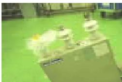
手順一6 注射針を封印部に挿入してコンデンサ油をサンプリングする
