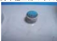
手順-3 封印栓の上部の円形状抑え金具とバネ座金を外す
